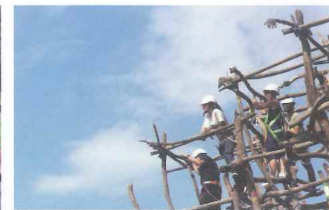
高空作業，等待吊裝單元
