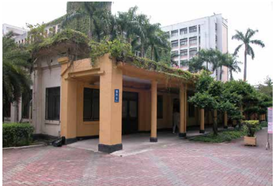
■ 現存於臺北科技大學內的亭仔腳建築
