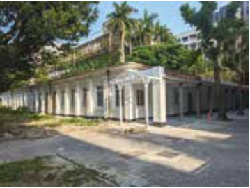
■ 一大川堂修復工程已竣工，室內規劃設置為校史館，展現古蹟活化風貌
