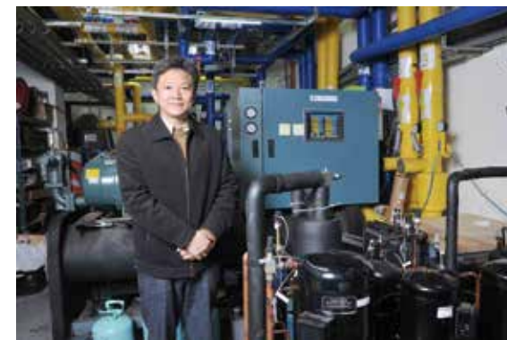
■ 臺北科大能源與冷凍空調工程系擁有全尺度之冷凍空調設備開發及智慧控制之實驗平台
