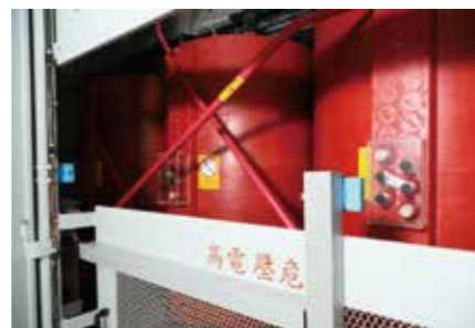
■ 無線熱影像模組 (圖中藍色機盒) 可點監控溫度並加速傳輸速度
