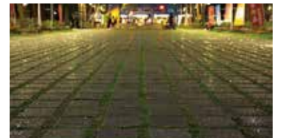
臺北科大為全台第一所大量鋪設透水鋪面的大學，透水鋪面也是排水減洪與降溫的關鍵
