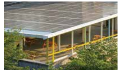
承德陽光活力廣場位於臺北科大圖書館屋頂，發電供校內行政大樓使用
