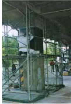
■ 碳纖維複合材料 (CFRP) 補強工法可提升建物的整體強度與韌性
