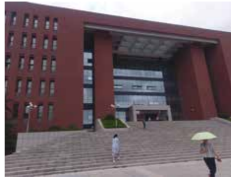
■ 大連理工圖書館
